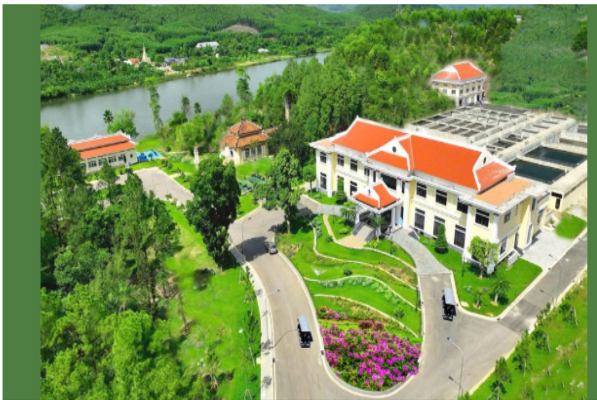
NHÀ MÁY NƯỚC VẠN NIÊN
